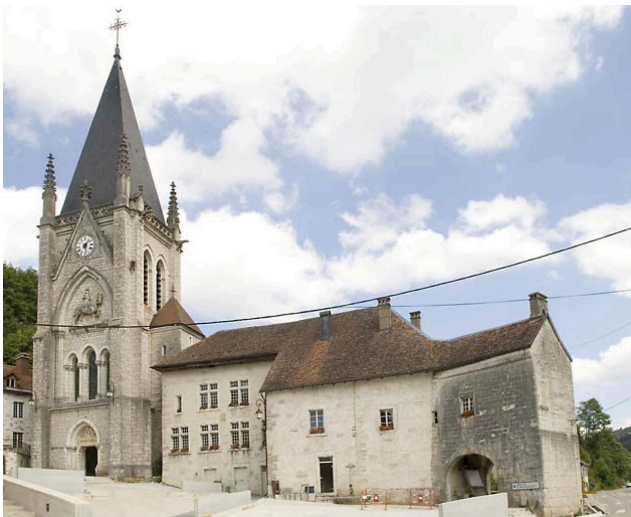
Vue d'ensemble des façades
