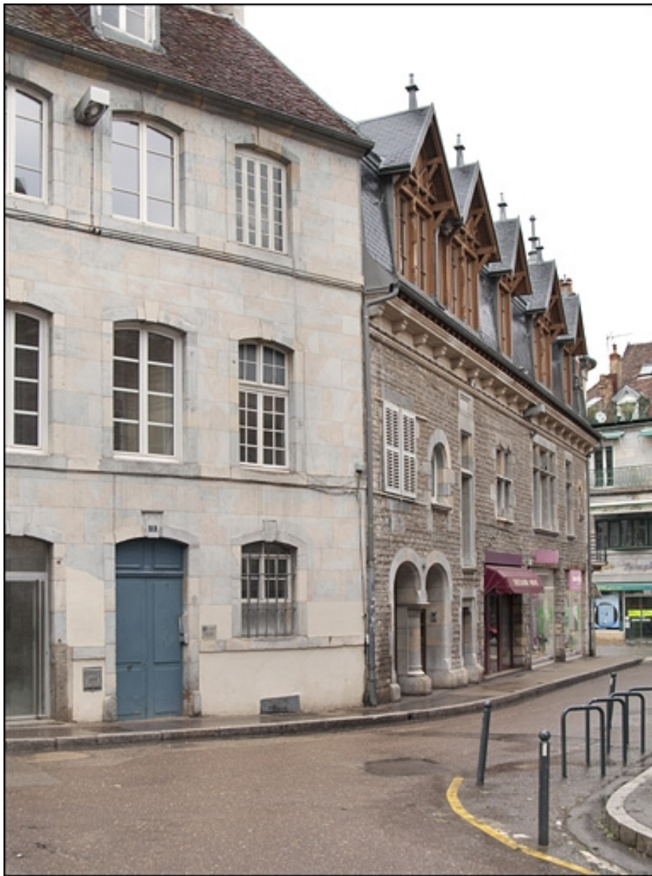
Vue d'ensemble de la façade située rue Luc Breton : de trois quarts gauche.
