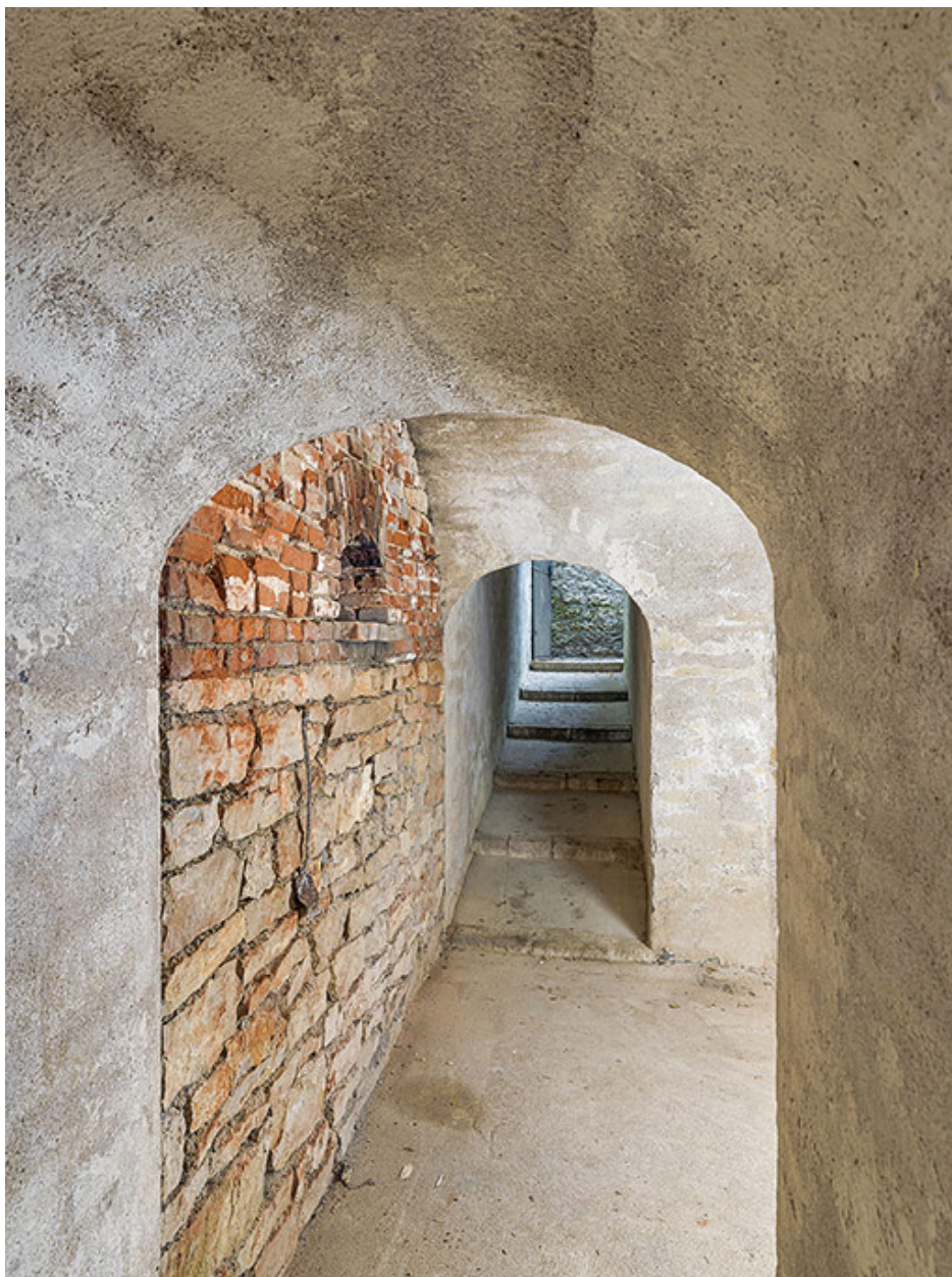
Passage vers les plateformes de tir (front de gorge).
