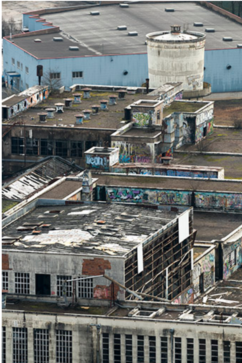
Etat en 2016. Usine A : toit des ateliers d'étirage et filature tergal et nylon, depuis l'ouest.
