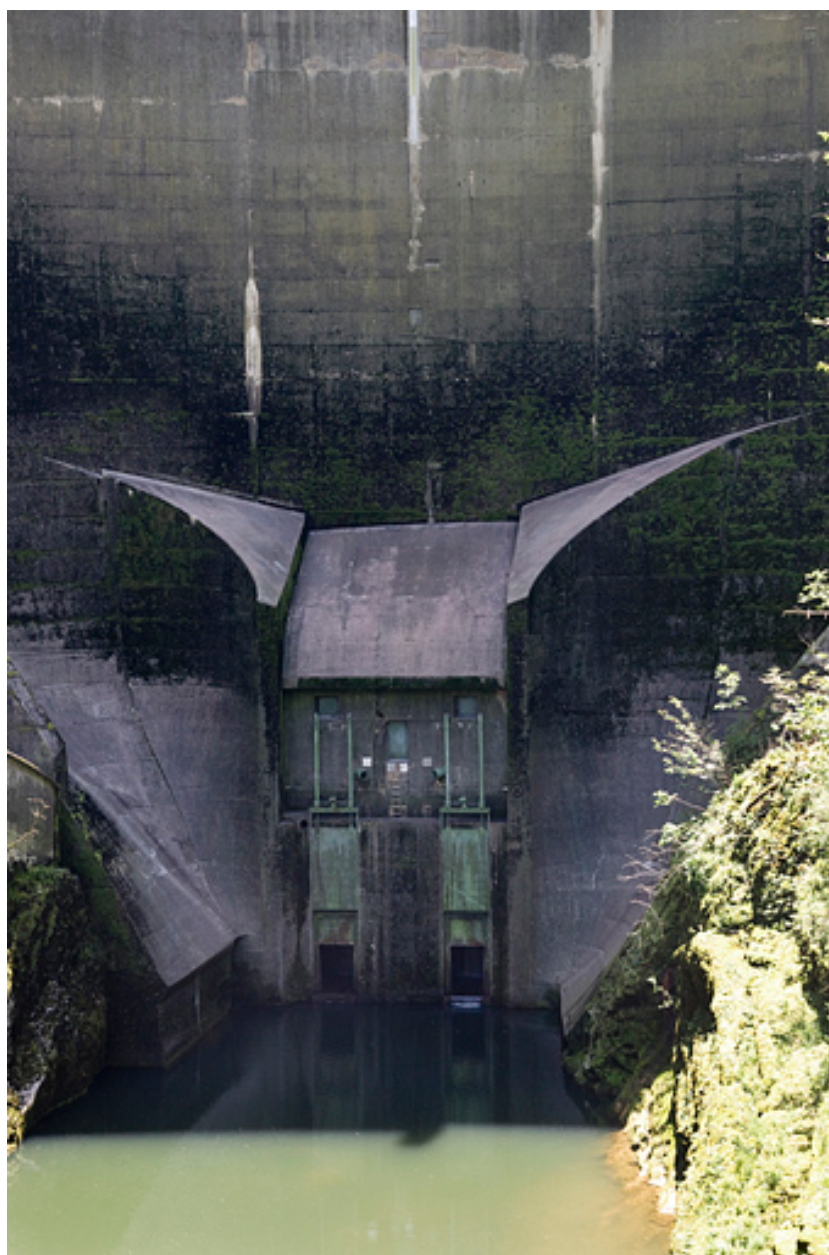
Barrage du Châtelot : vannes de fond.
