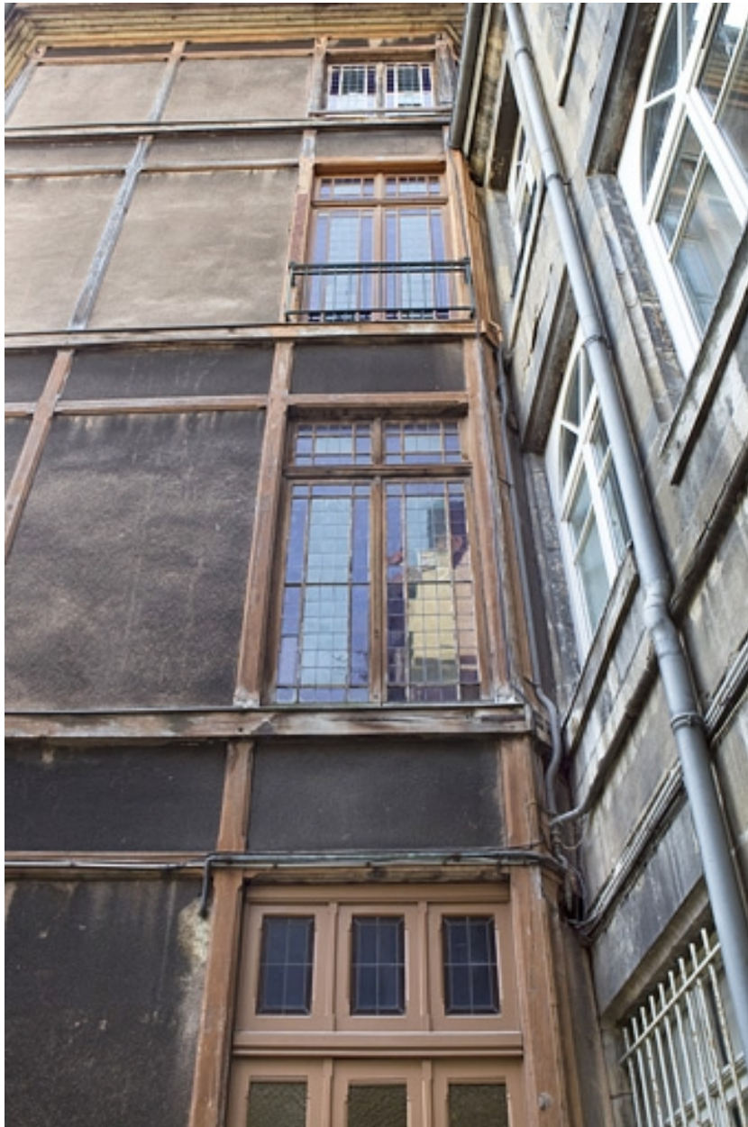
Détail de la paroi de la cage d'escalier en pan de bois.
