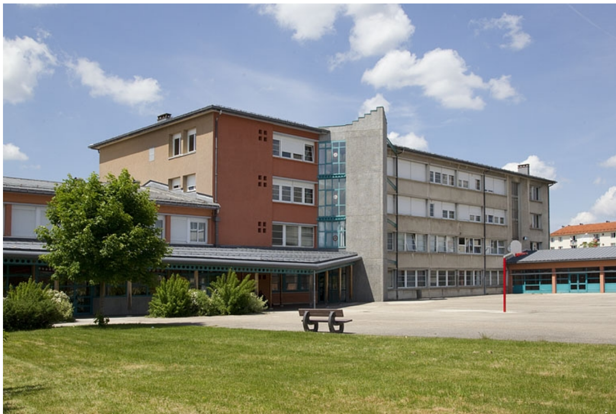
Bâtiment de l'hôtellerie, de trois quarts gauche.
