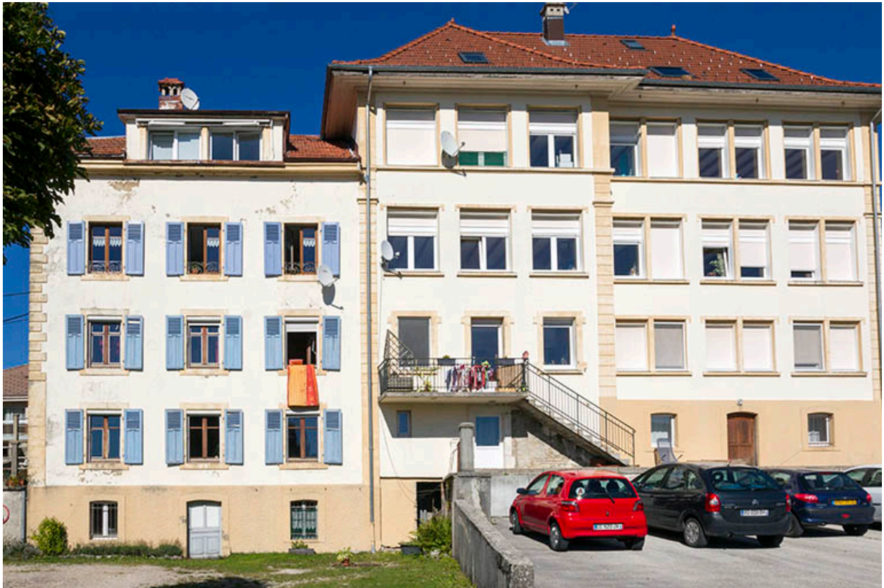
Maison et usine d'horlogerie Alphonse Dodane Fils puis Dodane Frères, 36-38 rue de l'Helvétie : façade postérieure.
