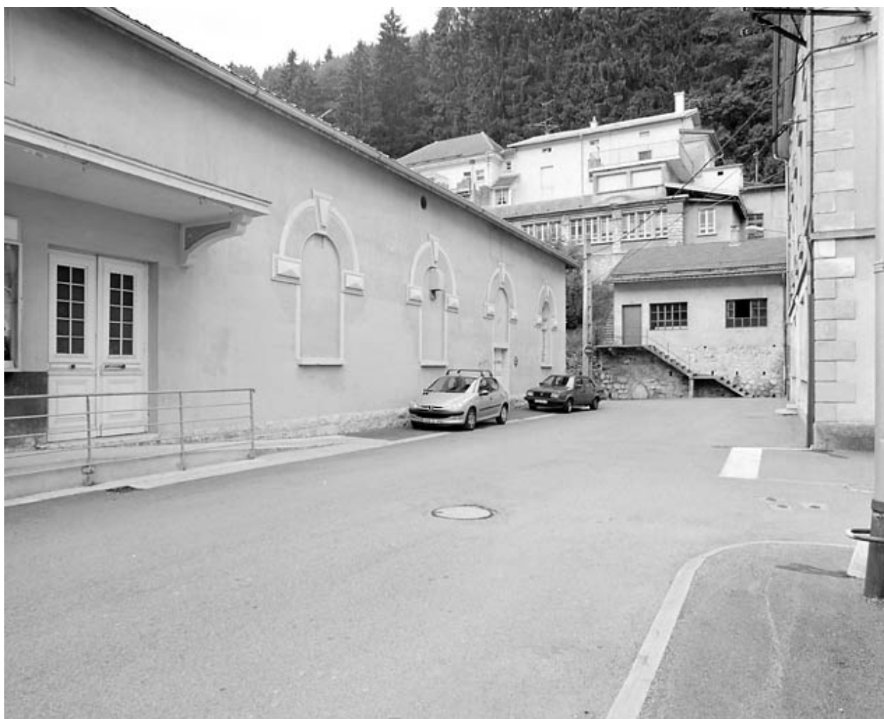
Elévation antérieure, de trois quarts gauche.
