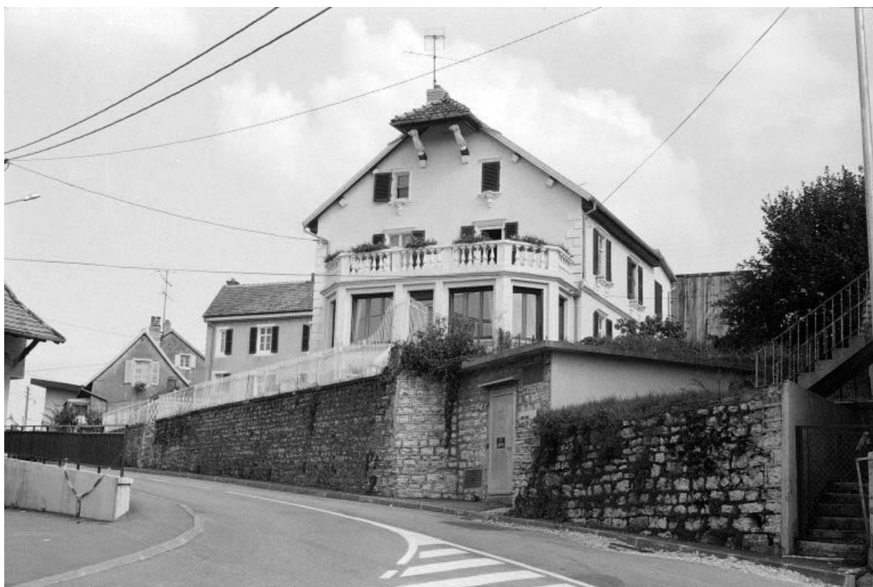
Façades latérale droite et postérieure.
