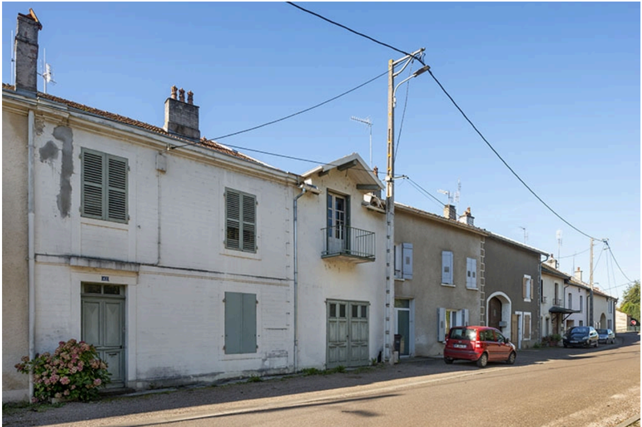
Trois quarts gauche des façades des maisons, 42, 40 et suivants, vers le nord-ouest.
