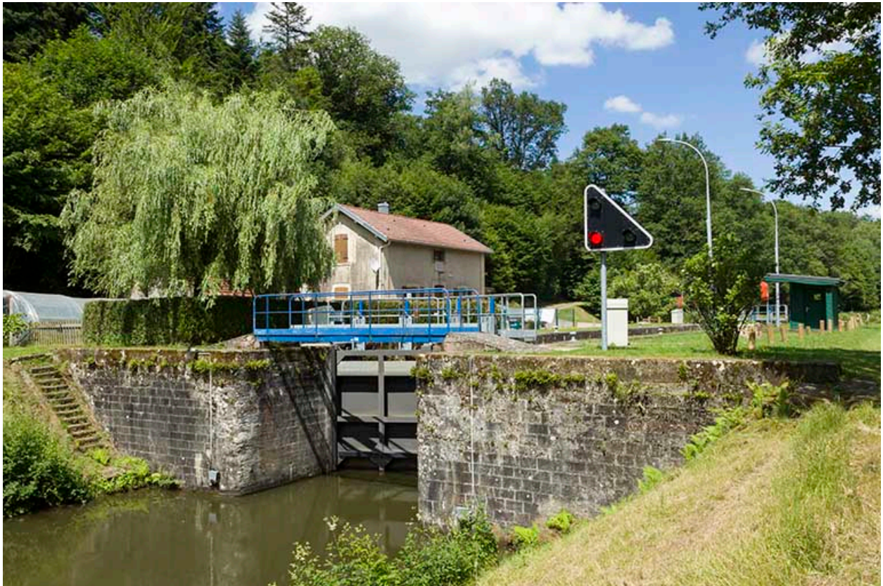
Vue d'ensemble depuis l'aval.
