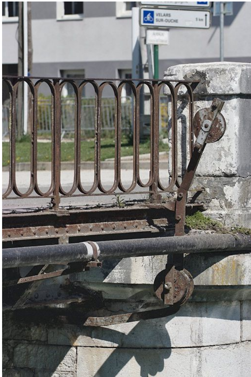
Détail du garde-corps et de la poulie.
