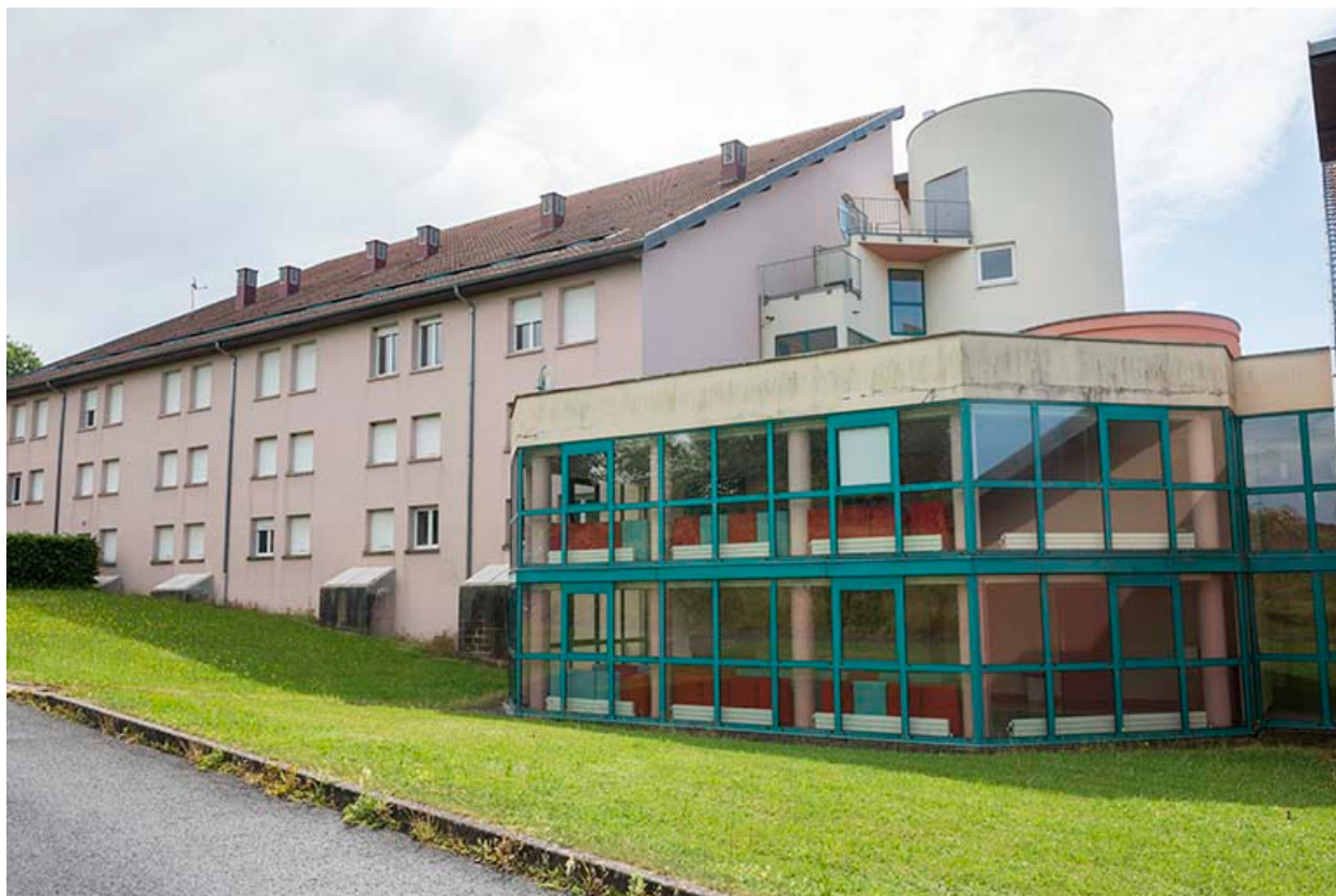
Façades postérieures nord de l'internat nord-est.
