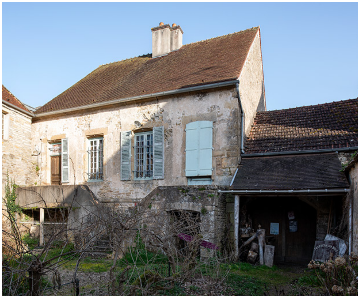
La façade du presbytère avec sa remise à droite.
