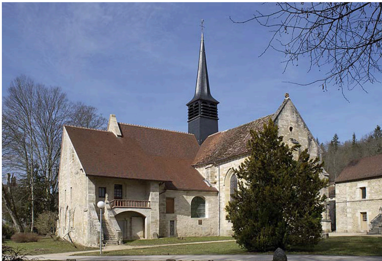
Extrémité nord de l'aile orientale vue de l'est.
