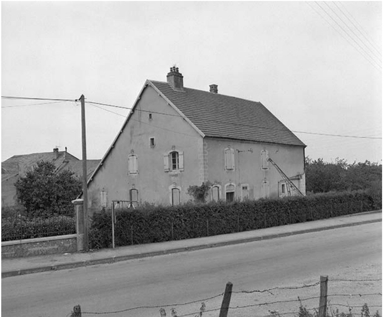
Maison située rue des Fontaines.
