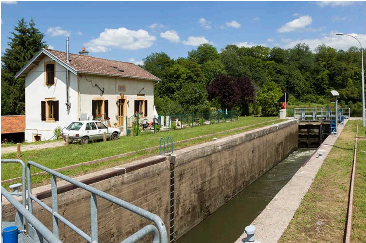
Le site d'écluse, depuis l'aval.
