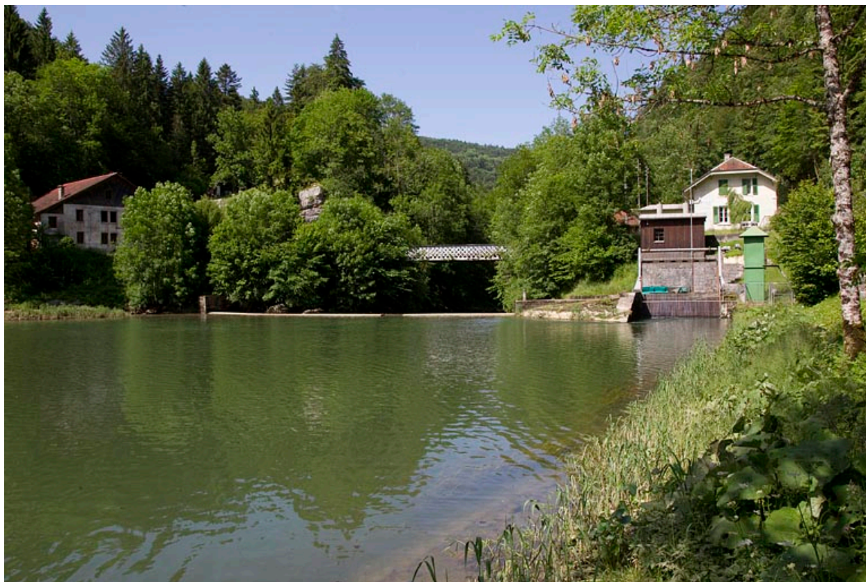
Barrage de la Goule (communes de Charmauvillers, France, et du Noirmont, Suisse), vu de l'amont.
