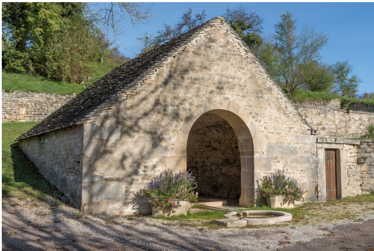
Vue de la façade ouest.
