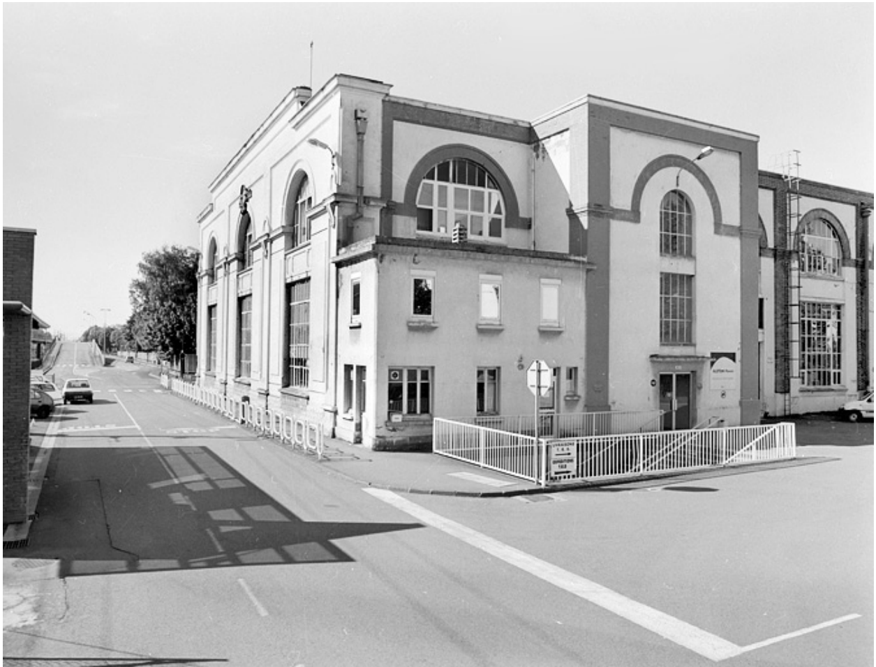
Bâtiment d'entrée à la porte des 3 Chênes, depuis le nord.
