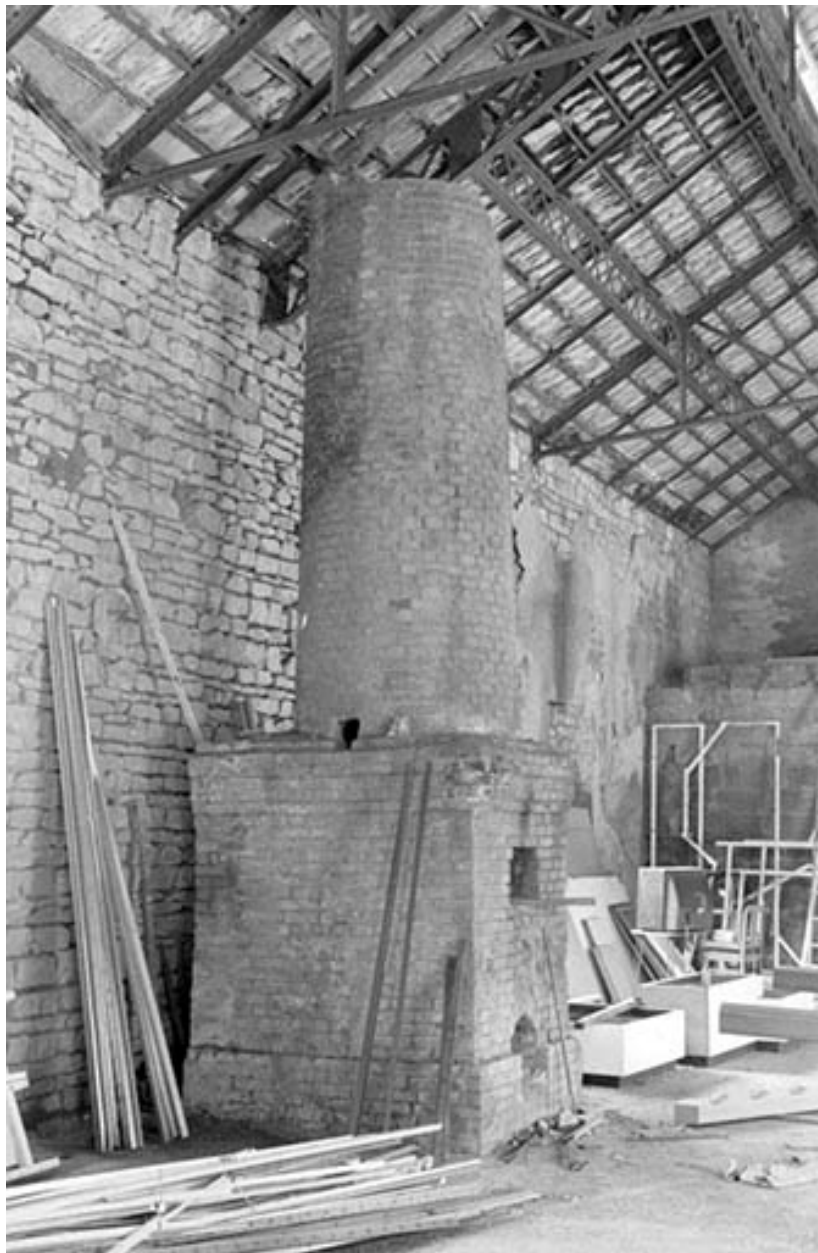
Atelier de réparation, intérieur : base de cheminée.
