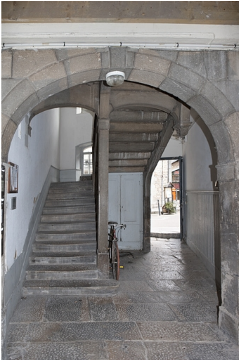
Détail du départ de l'escalier.
