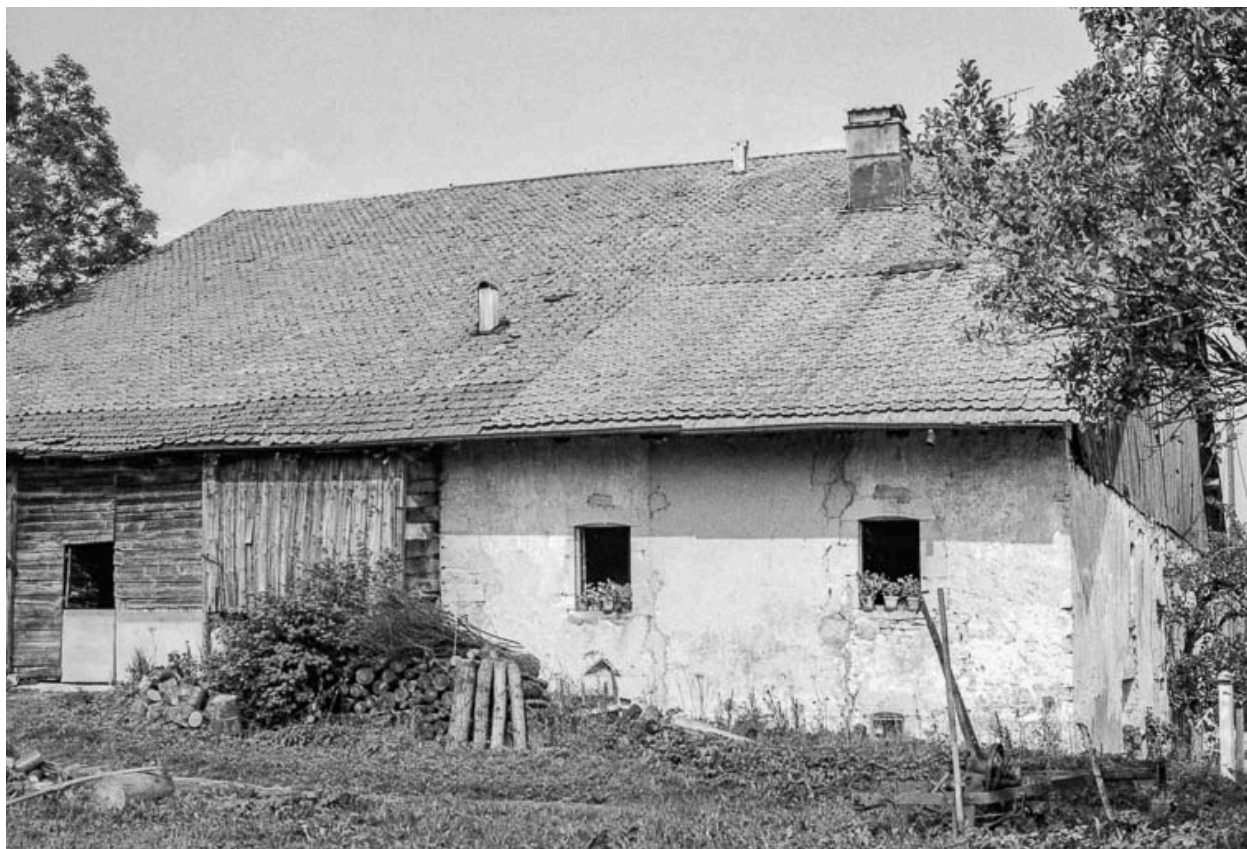
Ferme : façade postérieure.
