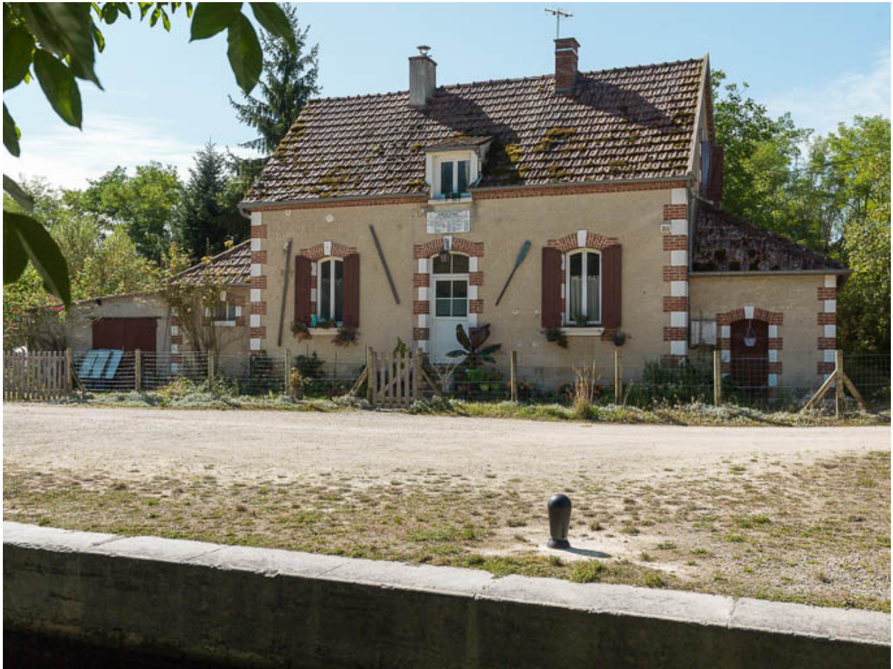
Vue de la maison éclusière.
