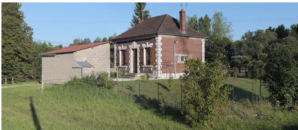
Maison éclusière : 3/4 arrière.
