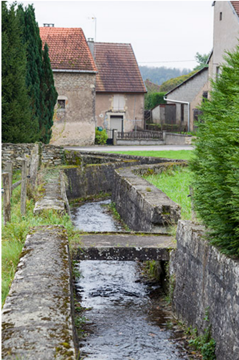
Le ruisseau canalisé traversant le village.
