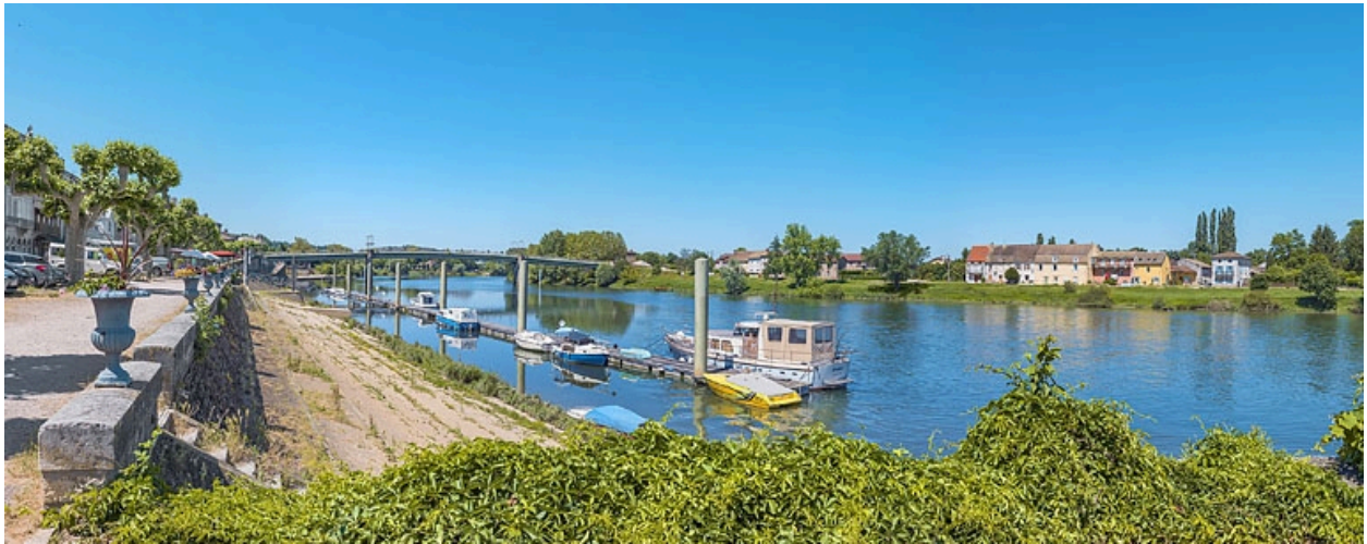
Vue d'ensemble des quais à gradins.
