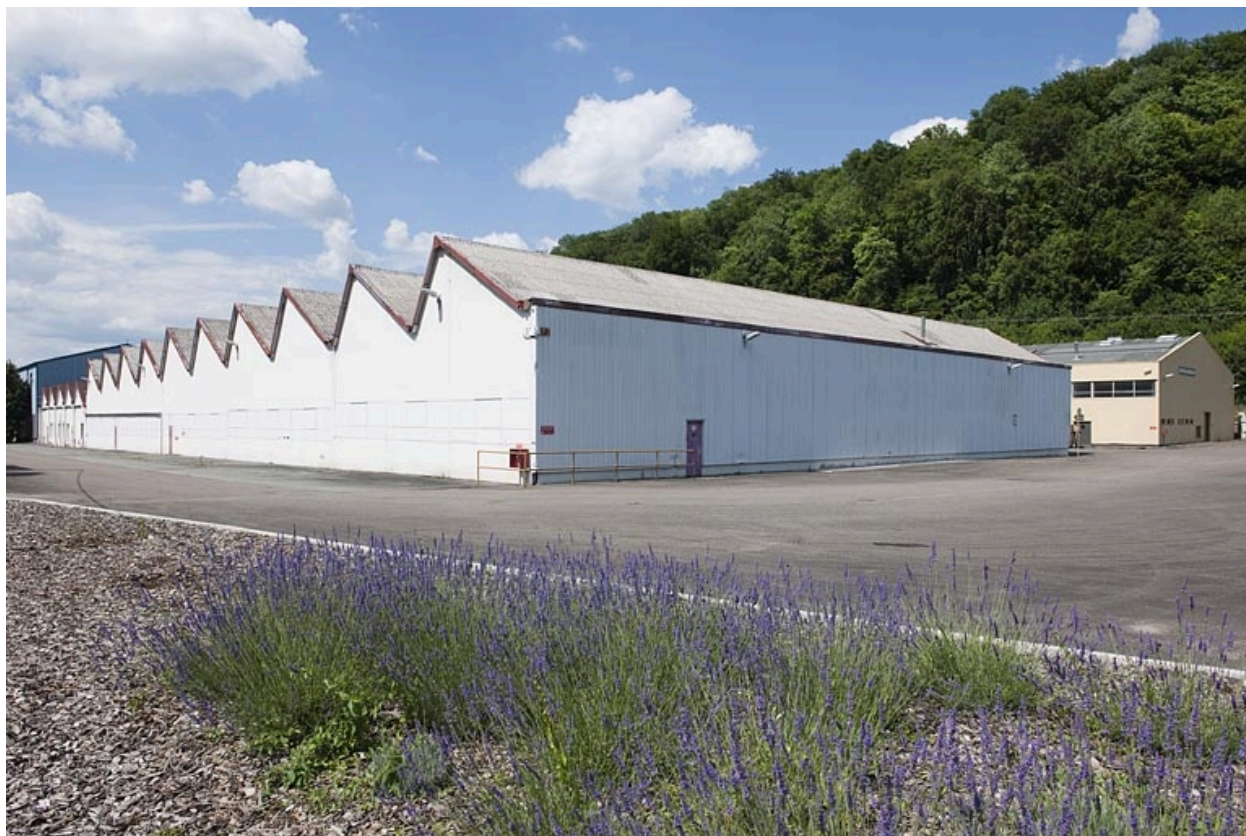
Entrepôts industriels depuis le sud.
