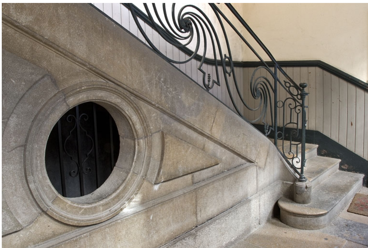
Logis principal : détail du départ de l'escalier.
