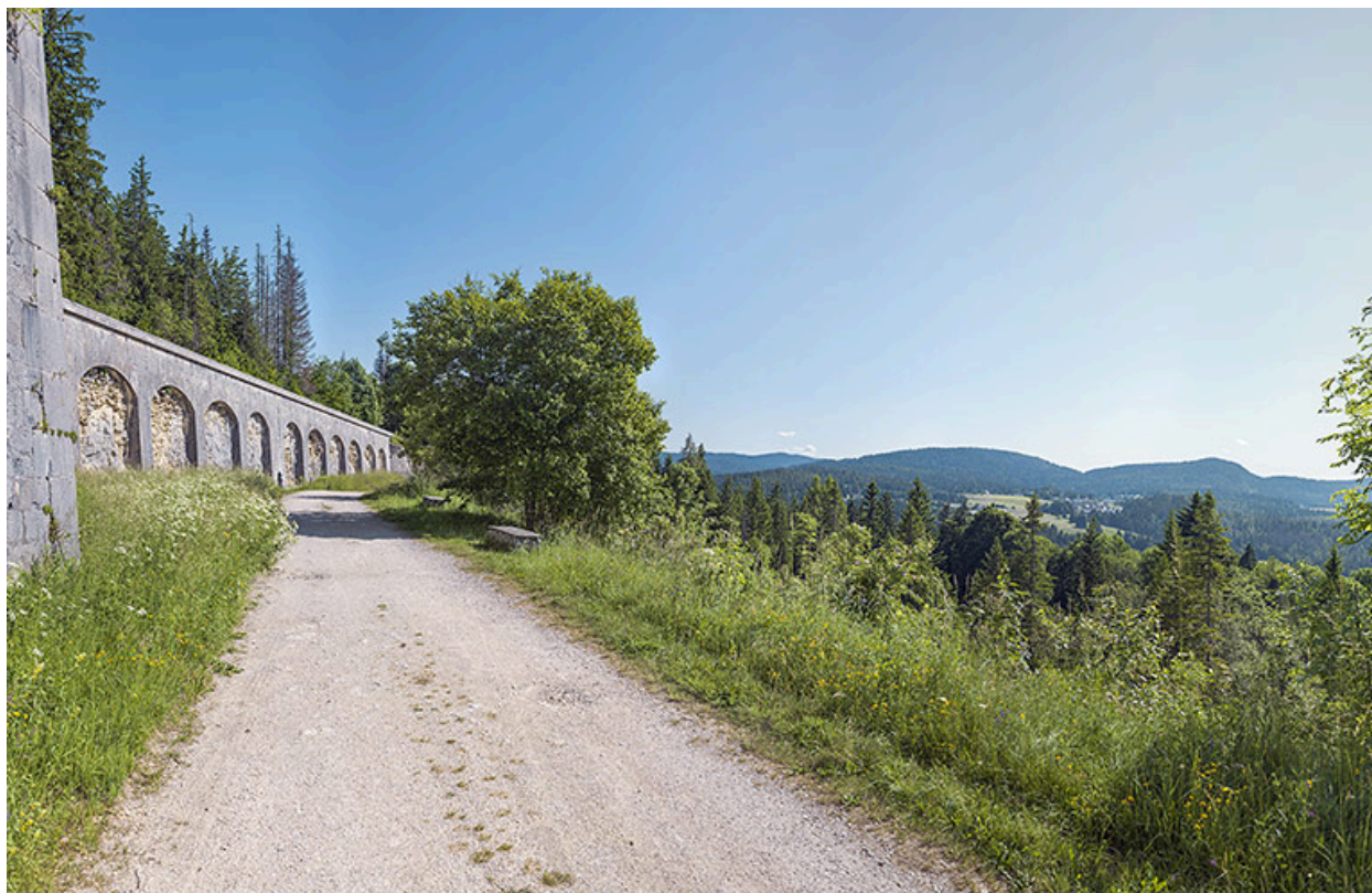
Front ouest et vue sur les monts de Prémanon.
