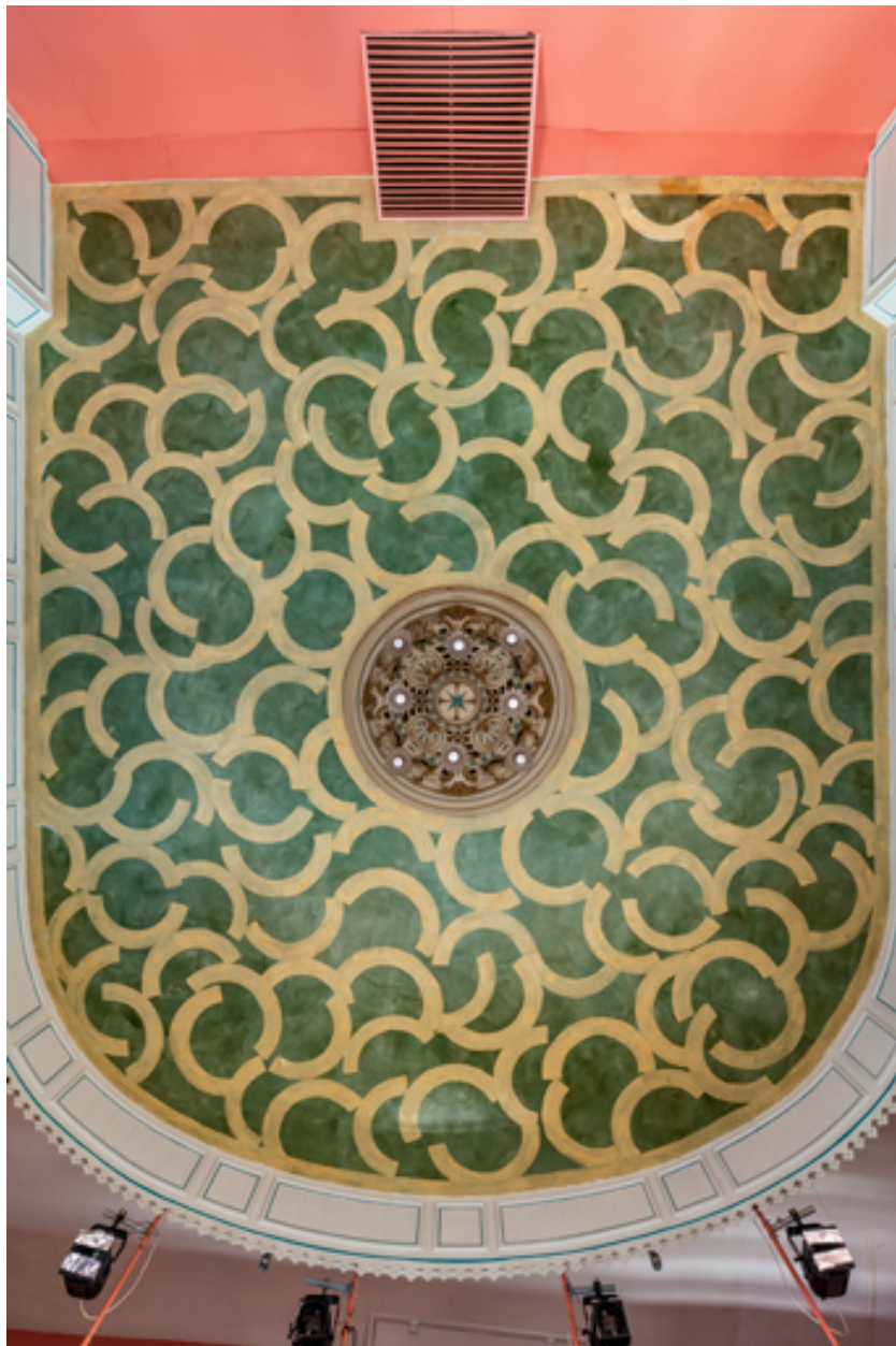
Vue d'ensemble du plafond.
