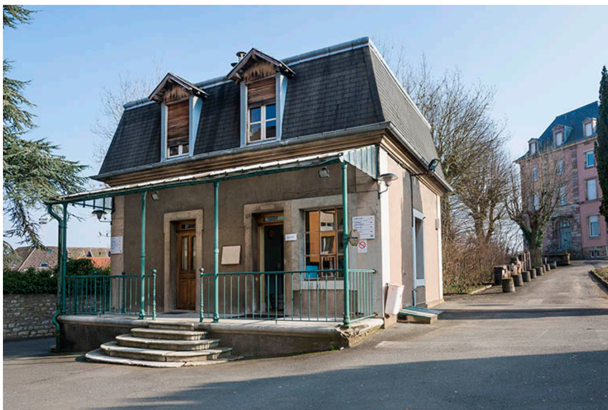
Façade antérieure (nord) de la conciergerie.
