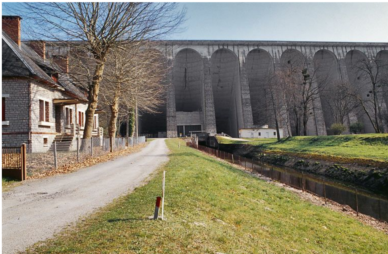
Vue d'aval : maisons et bureaux.
