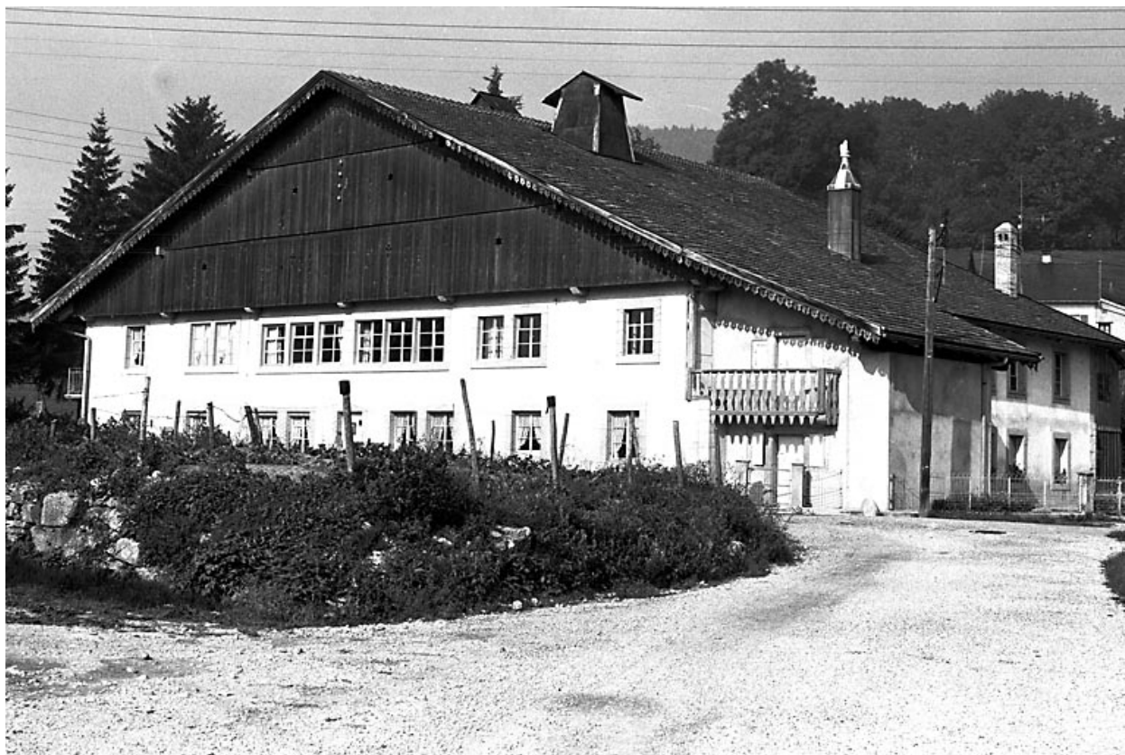
Vue d'ensemble en 1976 : façades antérieure et latérale droite.
