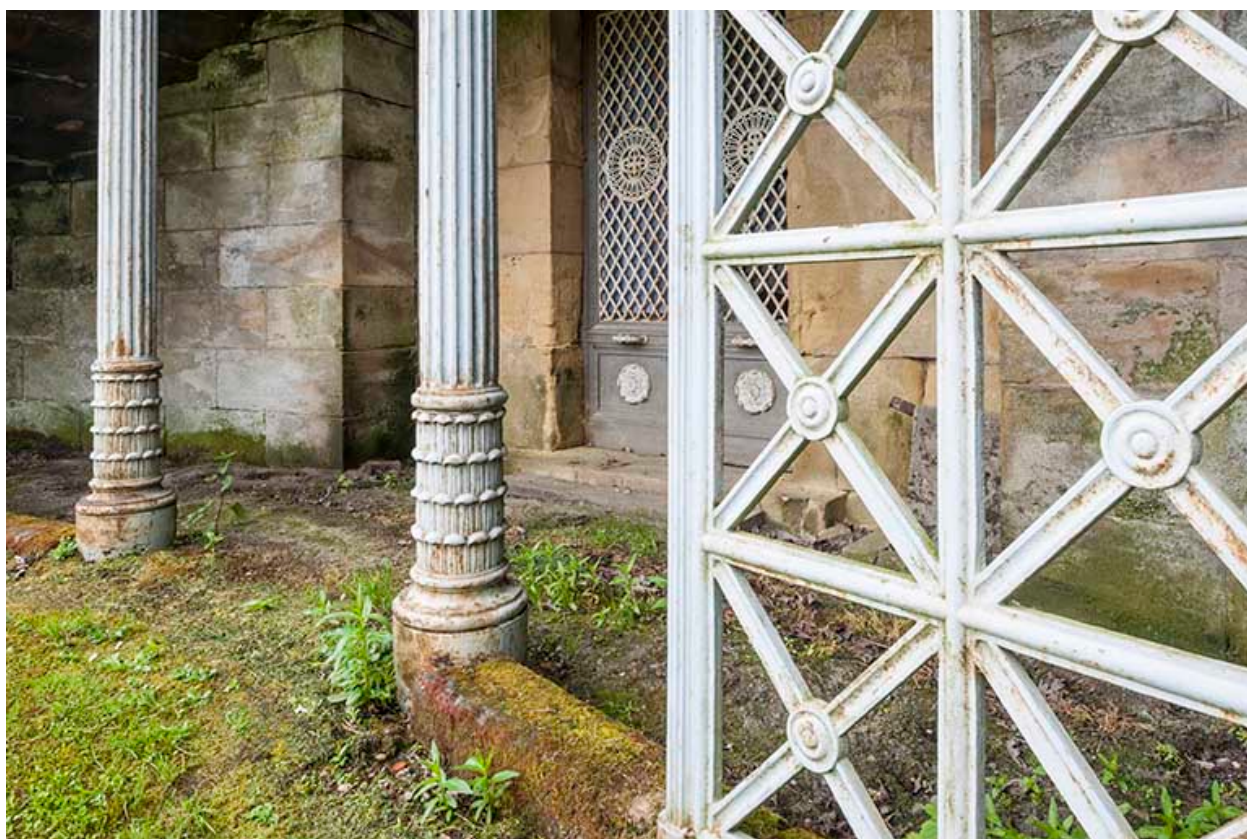
Détail sur l'armature métallique.
