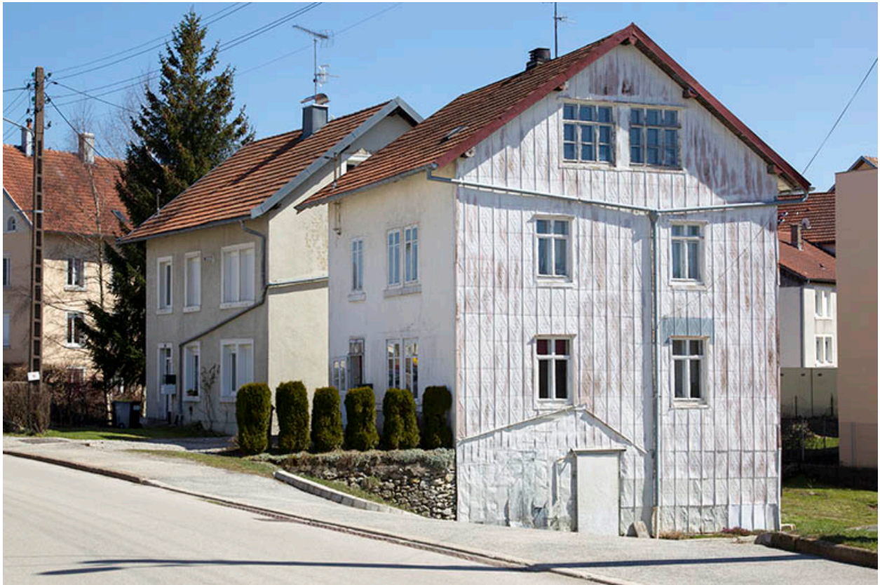
Maison et atelier d'horlogerie Janin, à Charquemont.
