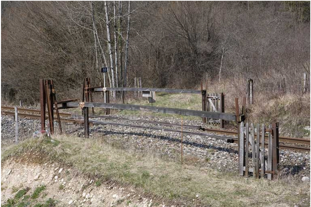
Passage à niveau n° 99, depuis le côté Andelot-en-Montagne.
