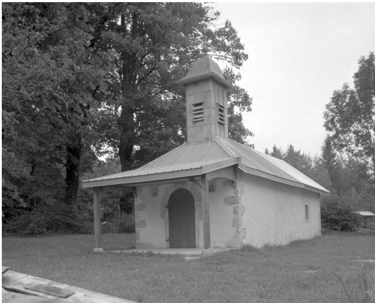
Façade antérieure de la chapelle.
