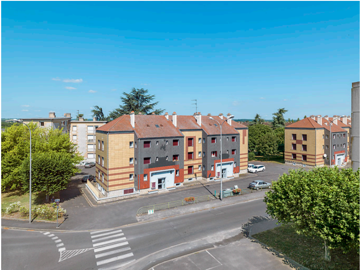
Bâtiment Binot-D, vue en situation.
