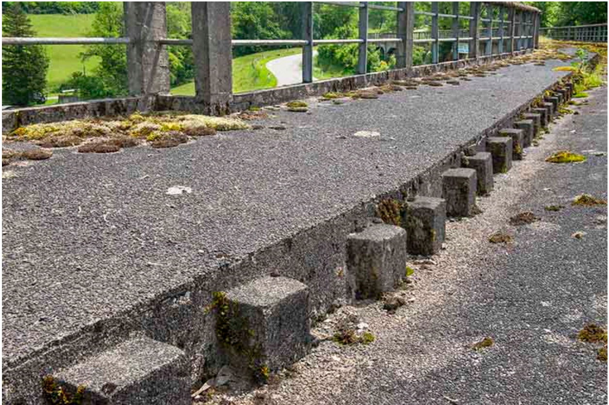
Détail du trottoir et de la chaussée.
