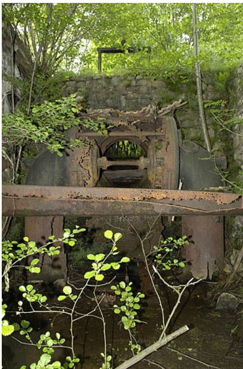
Vue d'ensemble de la turbine hydraulique.
