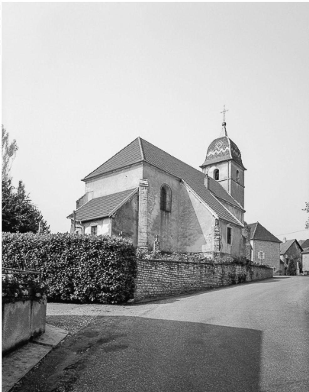
Extérieur : façades postérieure et latérale gauche.
