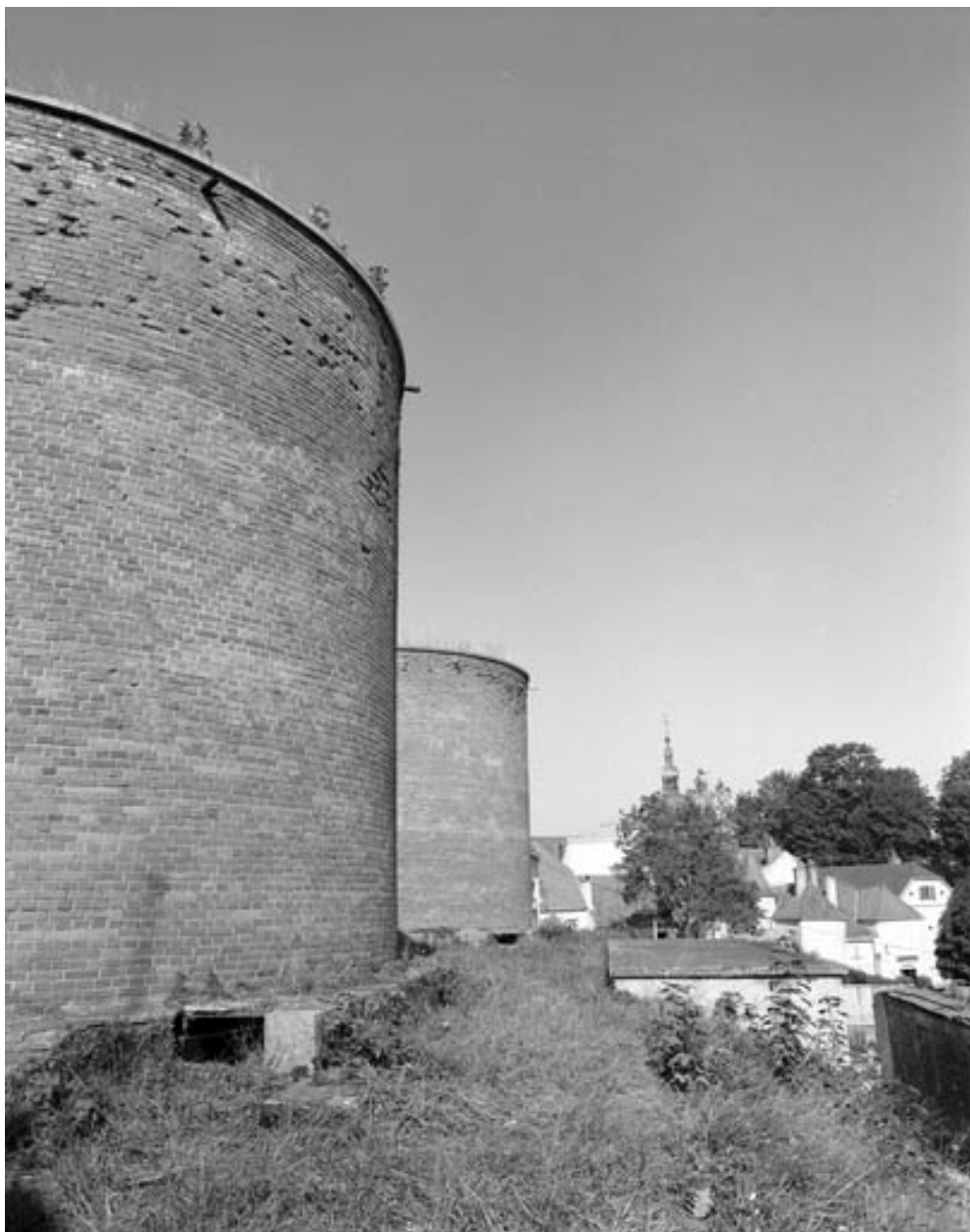
Les réservoirs : vue rapprochée.
