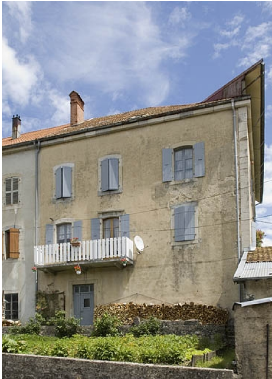
Façade postérieure de la partie sud.
