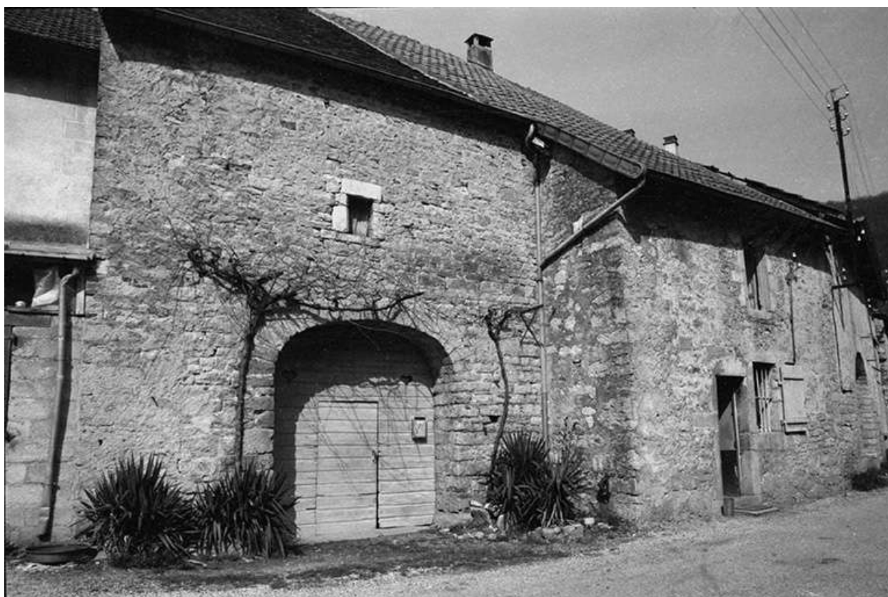
Ferme cadastrée 1964 AB 54 : façade antérieure.
