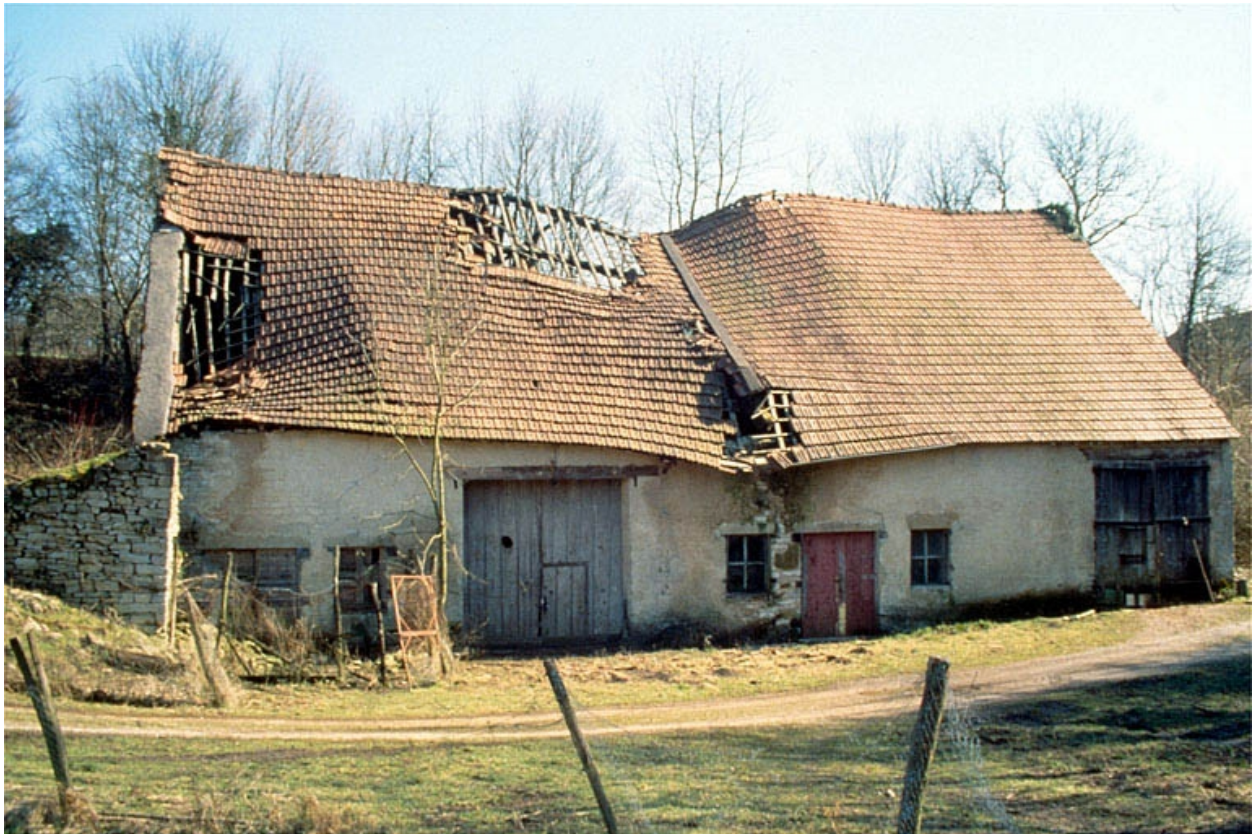
Façade antérieure de l'ancienne halle à charbon.
