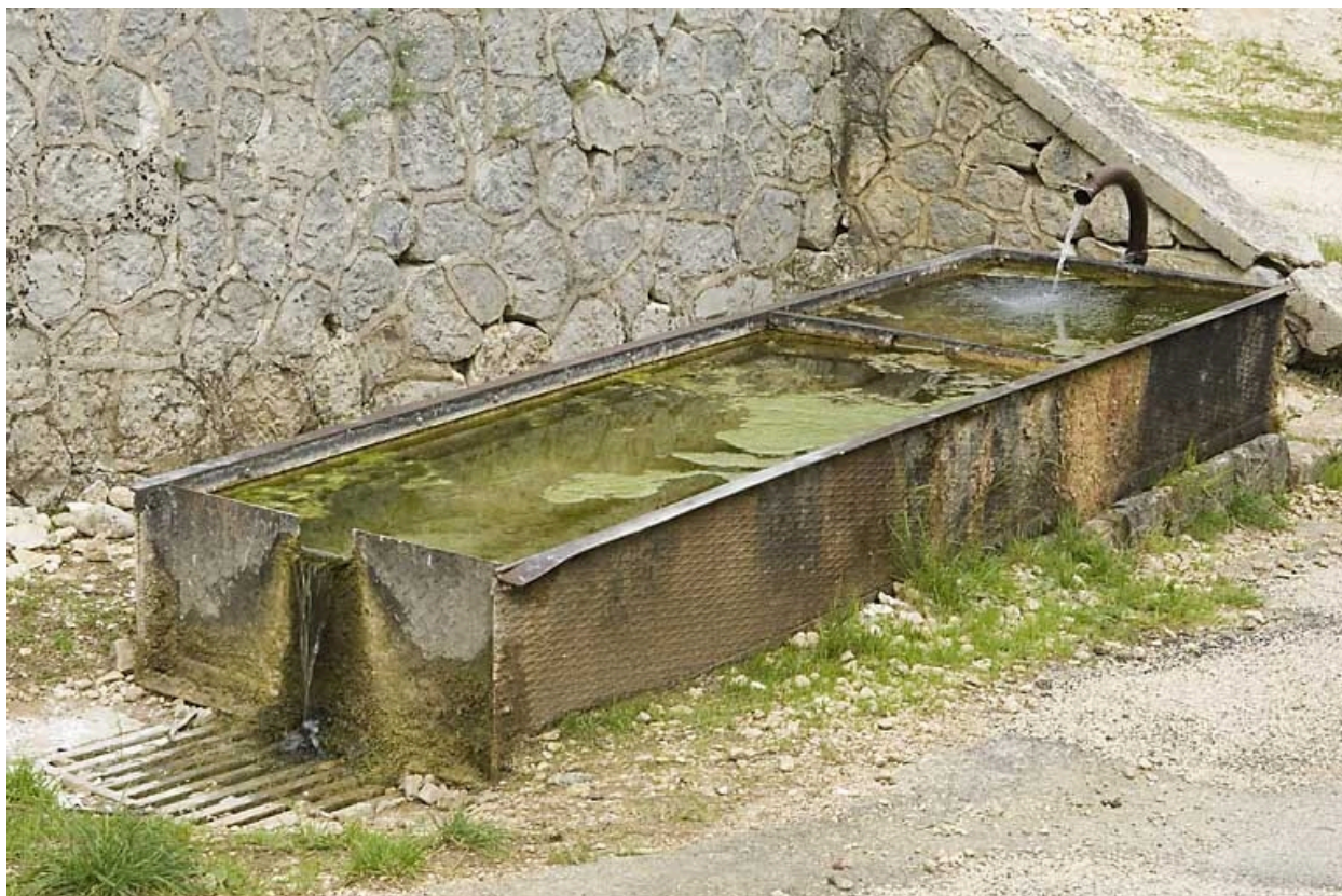
Fontaine-abreuvoir aux Tavins (rue de la Piquemiette) : vue rapprochée.
