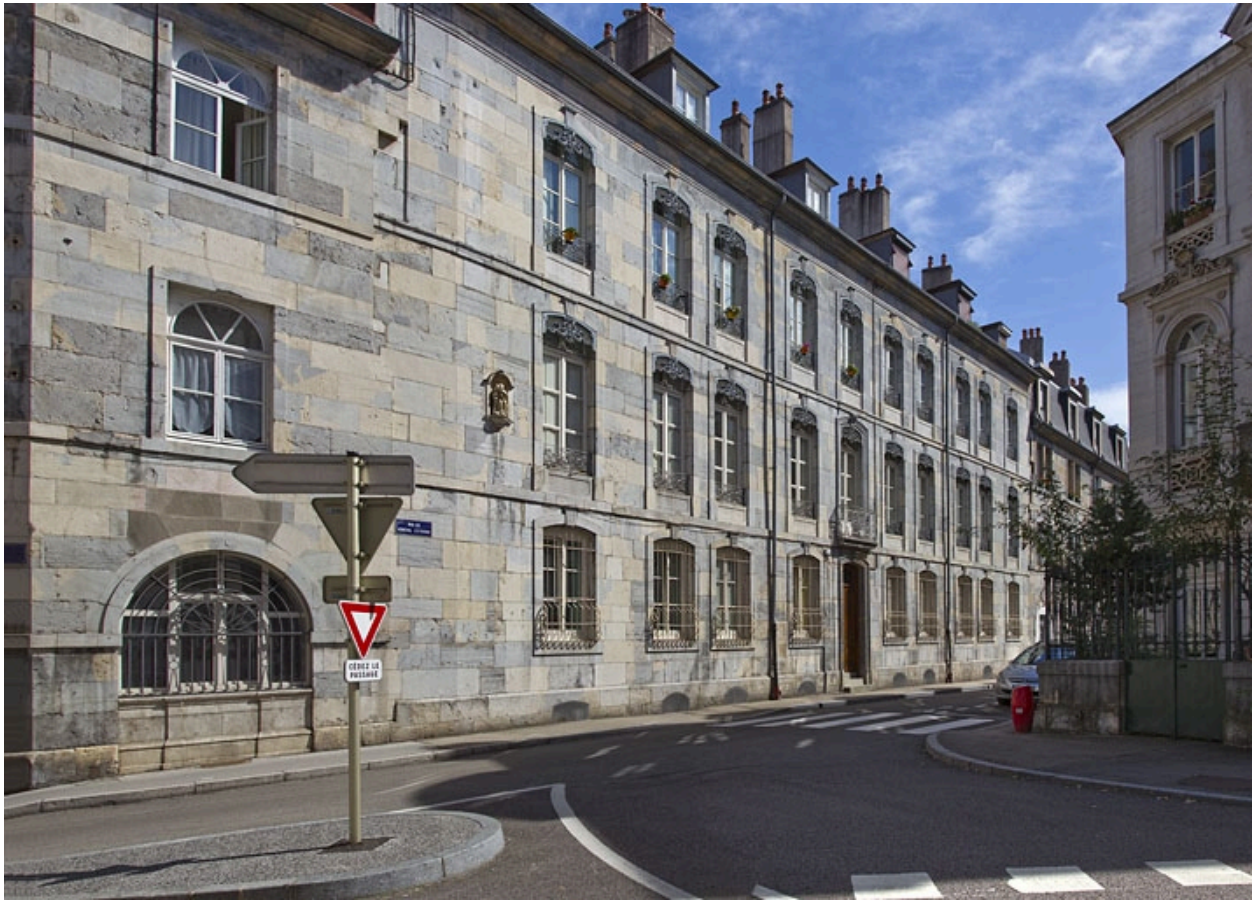
Vue d'ensemble depuis la rue, de trois quarts gauche.
