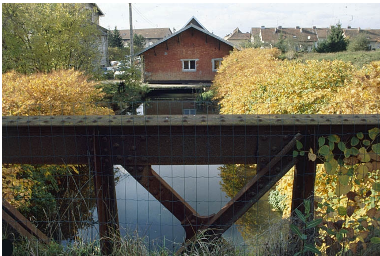
Passerelle sur le canal d'amenée.
